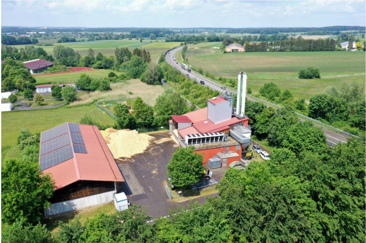
Heizkraftwerk Aichach Außenaufnahme
